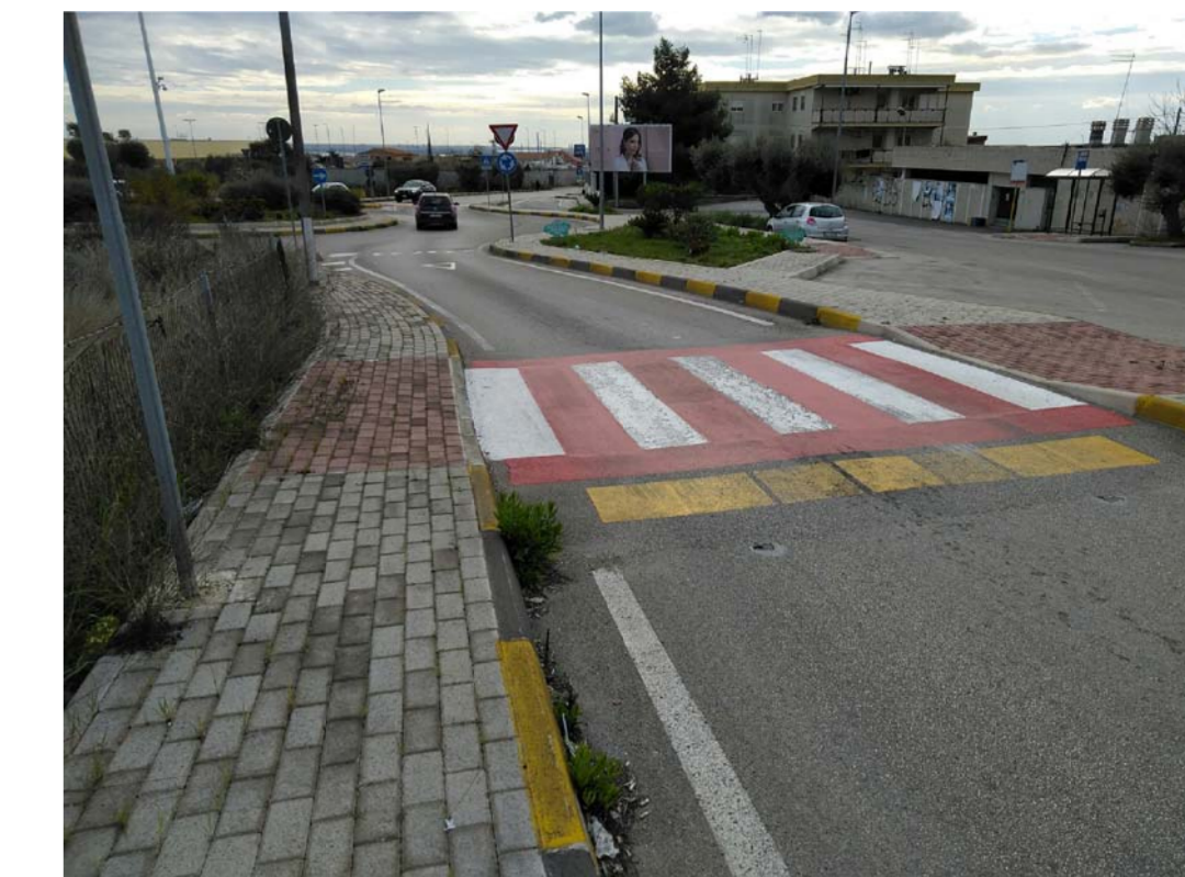
ATTRAVERSAMENTO PEDONALE SP. 48 VIA TARANTO
